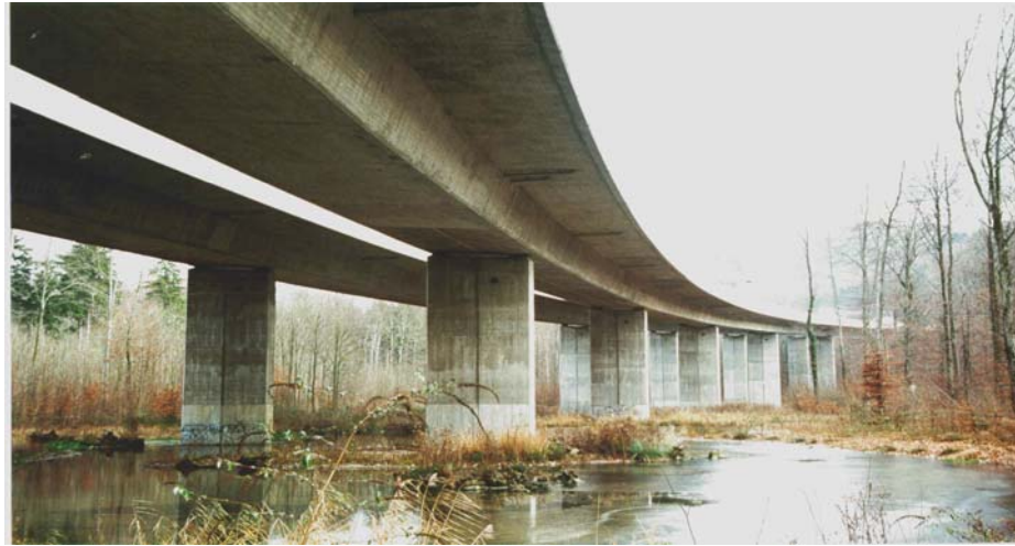
Bild 6: Aarebrücke der A3 bei Schinznach/AG mit aquatischem System, Inge, Bänziger +Partner FF, 1988-93
