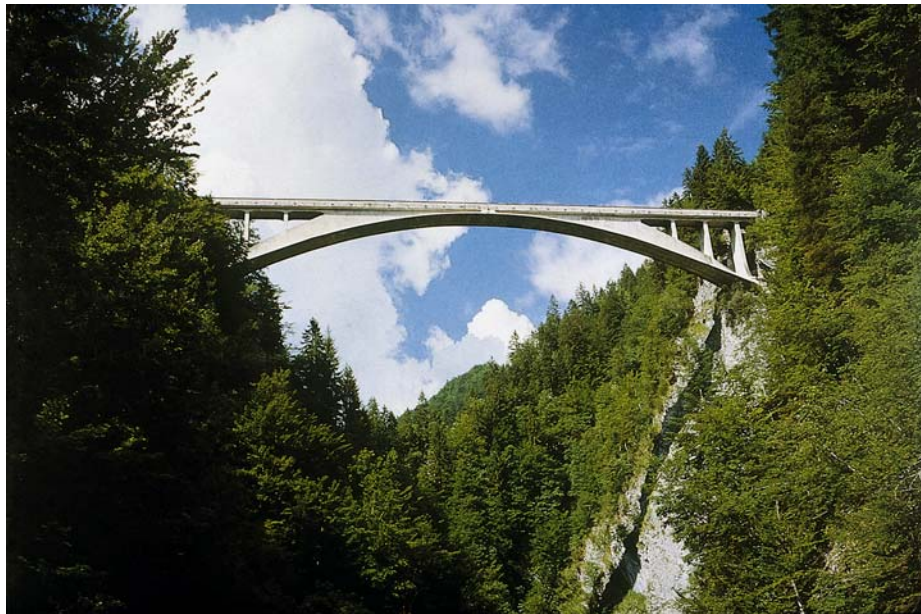
Bild 1: Salgintobelbrücke bei Schiers/GR, Robert Maillart, 1930
