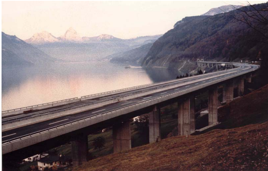
Bild 8: Lehnviadukt Beckenried der A2, Inge, Bänziger+Partner, 1976-80
