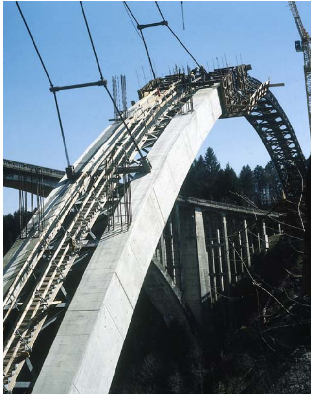
Bild 9: Hundwilertobelbrücke, AR, Bänziger+Partner, 1989-91
